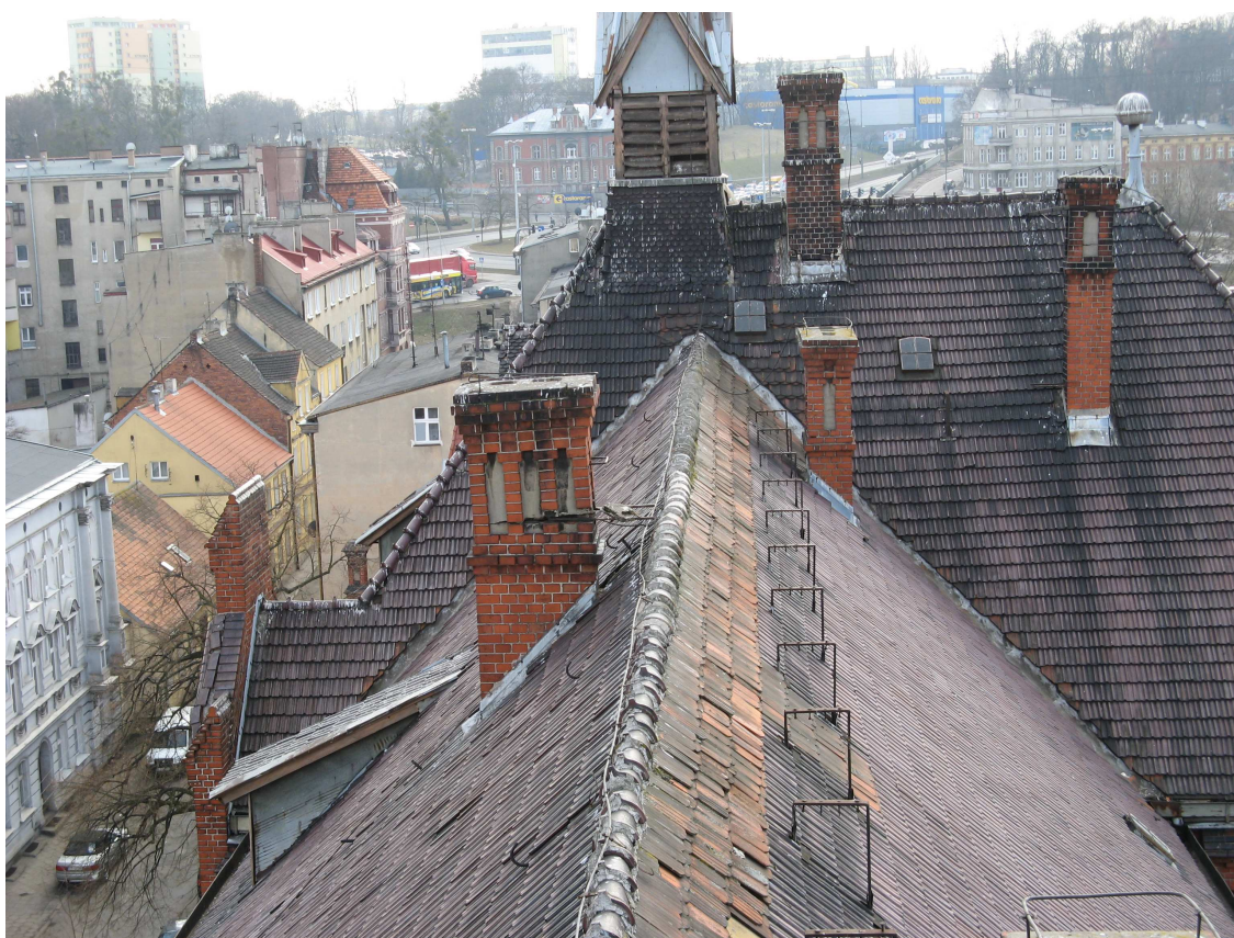
FOT. nr 10. DACH POKRYTY DACHÓWKA CERAMICZNĄ HOLENDERKĄ
