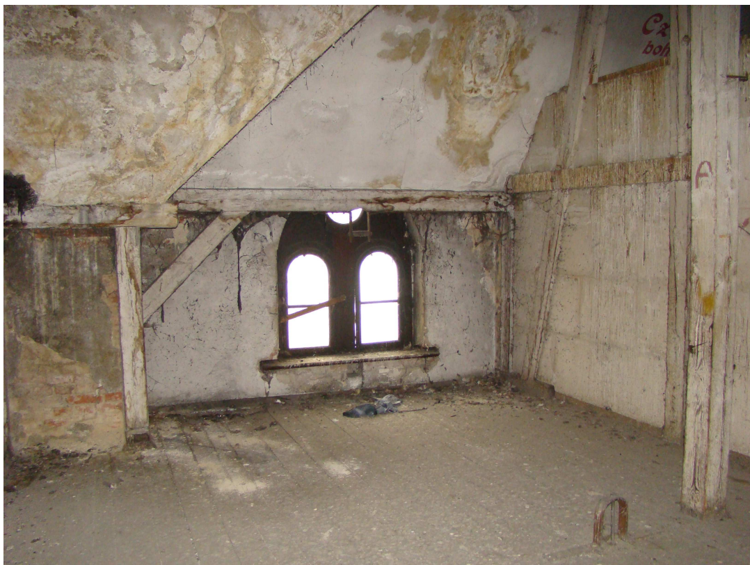
FOT. nr 15. STOLARKA OKIENNA ŚCIANY ATTYKOWEJ ELEWACJI FRONTOWEJ
