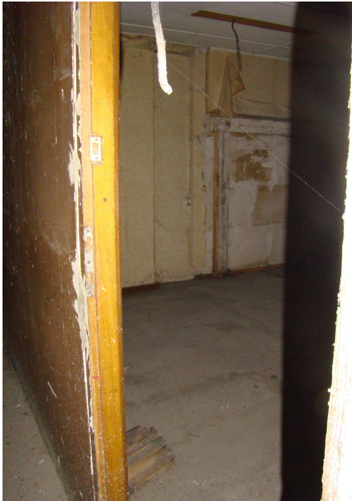
FOT. nr 5. WIDOK ŚCIAN DZIAŁOWYCH Z PŁYT PRO-MONTA
