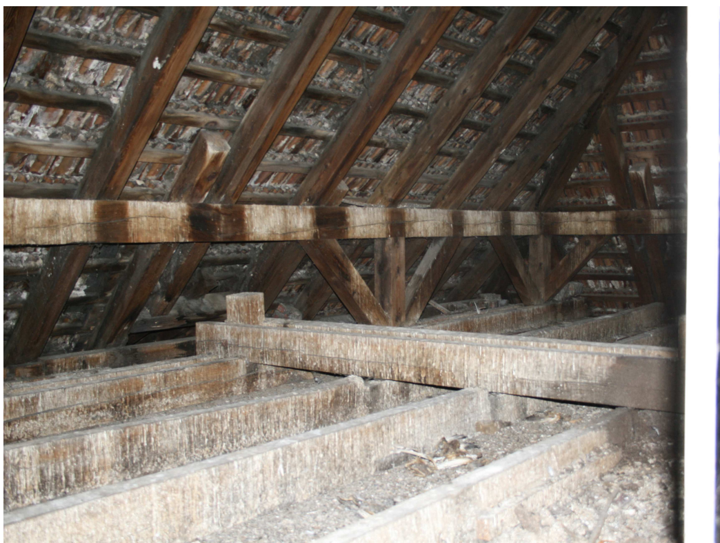
FOT. nr 14. KONSTRUKCJA WIĘŻBY DACHOWEJ PONAD STROPEM NADPODDASZEM
