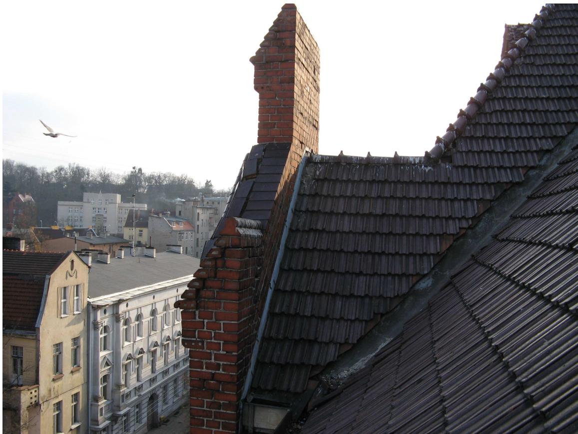
FOT. nr 4. WIDOK ŚCIANY ATTYKOWEJ
